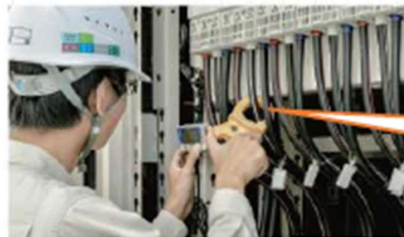
◀ 測定器取付け写真
